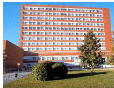
Facultad de Filosofía – Edificio B
