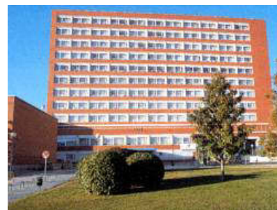
Facultad de Filosofía – Edificio B
